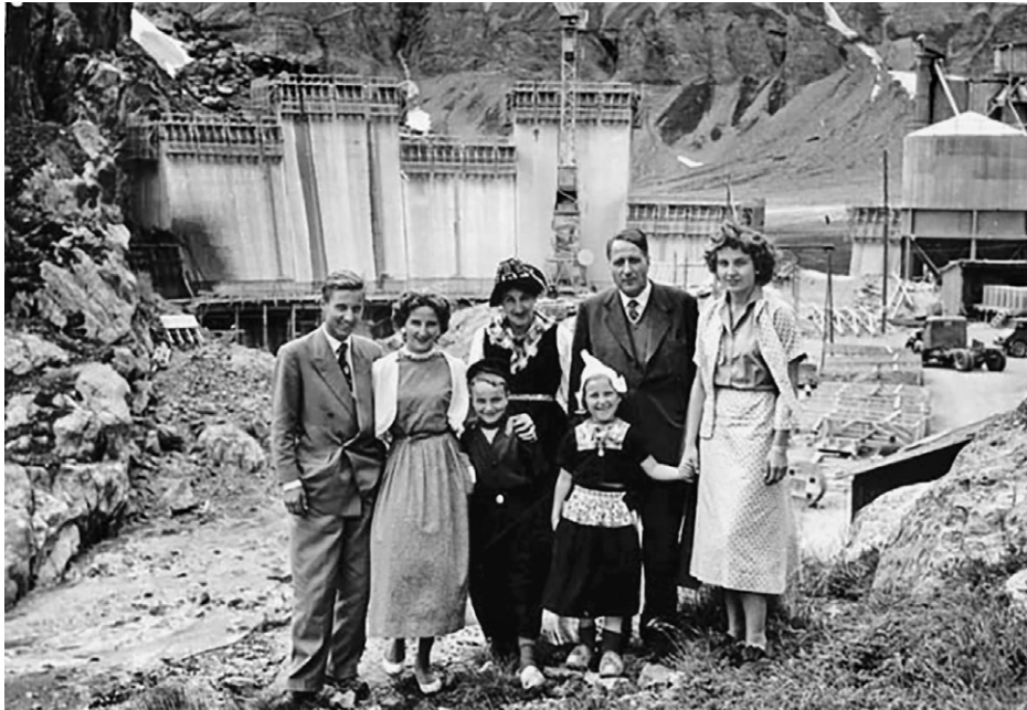
Sonntagsausflug zur Baustelle, Emosson, zwischen 1967–1973. © Roger Dorsaz, Treize Etoiles, Médiatheques Valais - Martigny (081phC03a02-023).
