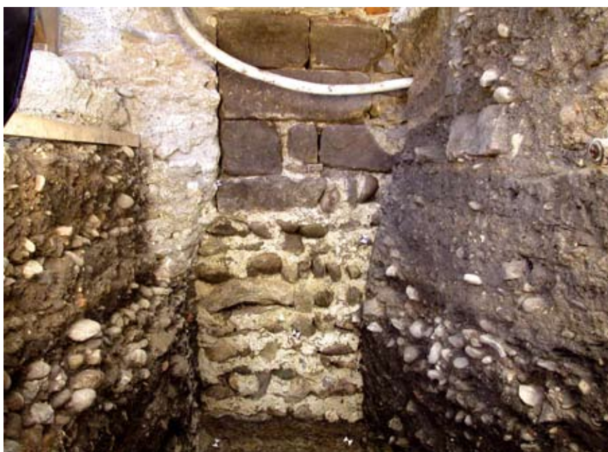
Abb. 32 Münsterplatz (A) 20 (2004/38). Ansicht des Sandstein-Eckverbandes der südwestlichen Ecke des Kernbaus im heutigen Rollerhof. – Foto: Udo Schön.
