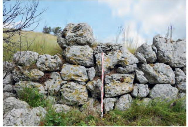
Abb. 71 Monte Auro (HB40). Foto eines Mauerdetails von UM3 mit Baunaht.
