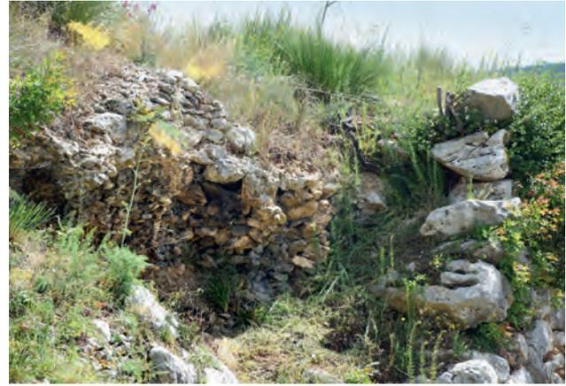
Abb. 36 Mauerkurte rechts und Hinterfüllung links. Monte Cila (HB55).
