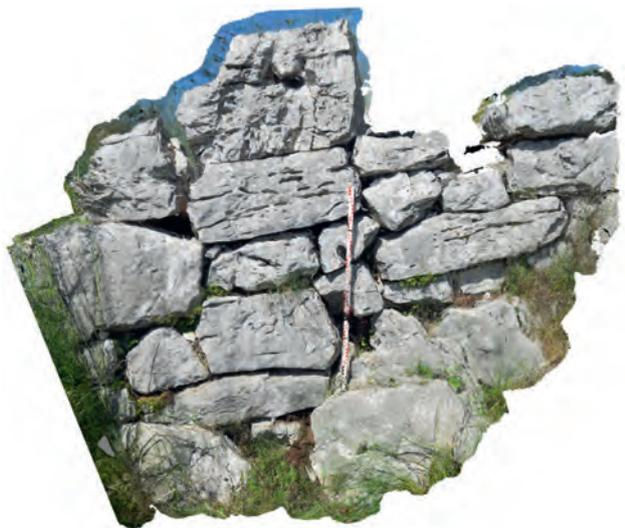
Abb. 70 Monte Auro (HB40). Fotogrammetrie eines Details von UM3 mit Baunaht.
