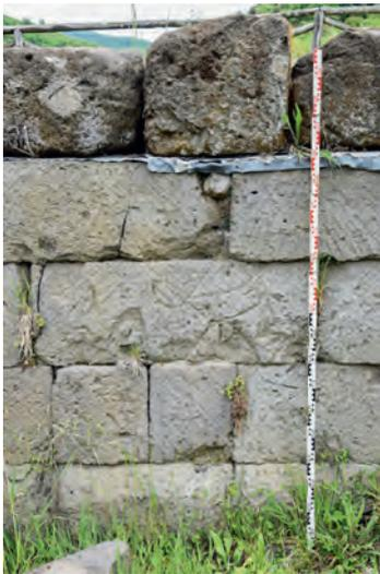
Abb. 30 Tuffquader-Mauerwerk im angebauten Korridor des Haupttors von Treglia mit oskischem Steinzeichen.
