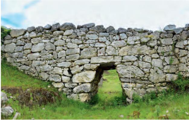
Abb. 29 Bruchsteinmauer in Treglia (HB105). Ansicht des Haupttors.
