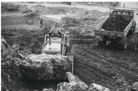
92 Aushubarbeiten anlässlich des Baus des Thermalhallenbads 1963. Der Einsatz moderner Baumaschinen machte den Abbruch auch massivster römischer und mittelalterlicher Bausubstanz möglich.
