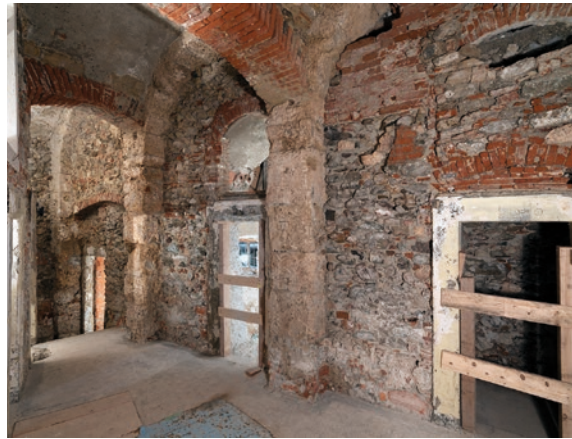
131 Hotel Ochsen. Das Badehaus bei der Paradiesquelle mit den Spitzbogenarkaden datiert ins Spätmittelalter; im 17., 18. und 19. Jahrhundert erfolgen Umbauten zu den heute noch erhaltenen Badekellern.
