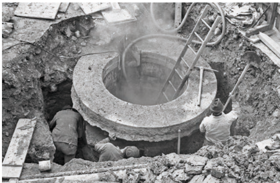
106 Arbeiten an der Fassung des Grossen Heissen Steins im Winter 1967/1968.
