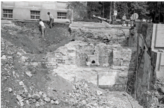
100 Baubegleitung Stadhof 1967. Die römische Apsis wurde 1968 in den Empfang des medizinischen Zentrums im Stadhof integriert.
