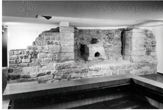
101 Baubegleitung Stadhof 1967. Die römische Apsis wurde 1968 in den Empfang des medizinischen Zentrums im Stadhof integriert.
