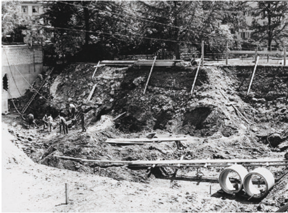
94 Aushubarbeiten für das Thermalbad von Otto Glaus 1963. In der Baugrube sind Ruinen und Schutt erkennbar. Blick gegen NE. Links die Wand der Wäscherei des Hotels Verena Hof, durch die Bäume sind die ehemaligen Hotels Rebstock/Hirschen (links) und Adler (rechts) in Ennetbaden erkennbar.
