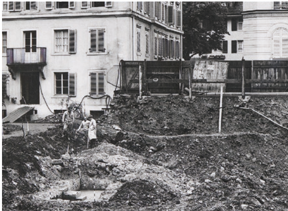
86 Paul Haberbosch (mit Hut) mit Arbeitern auf der Baustelle des Thermalbads 1963 zwischen dem alten Hauptgebäude des «Stadthof» (links) und dem Hotel Verenaahof.
