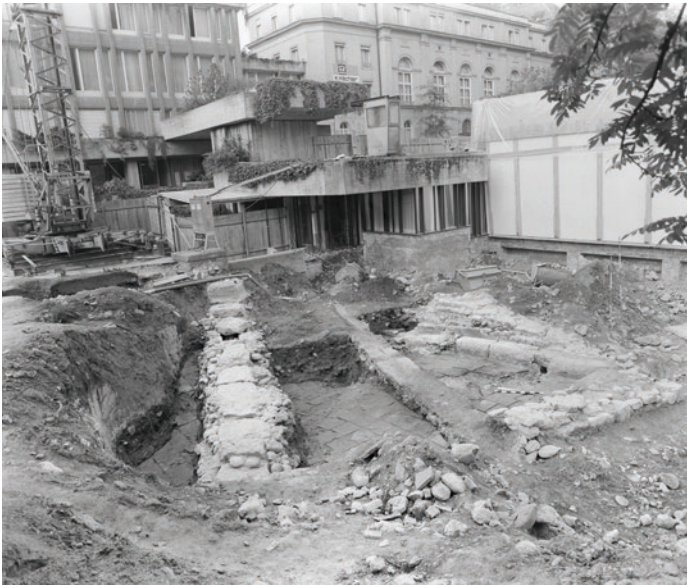
111 Blick auf die Ausgrabungen anlässlich des Baus des Aussenbads des Thermalbads 1980. Rechts das 1963/1964 erbaute Thermalhallenbad.
