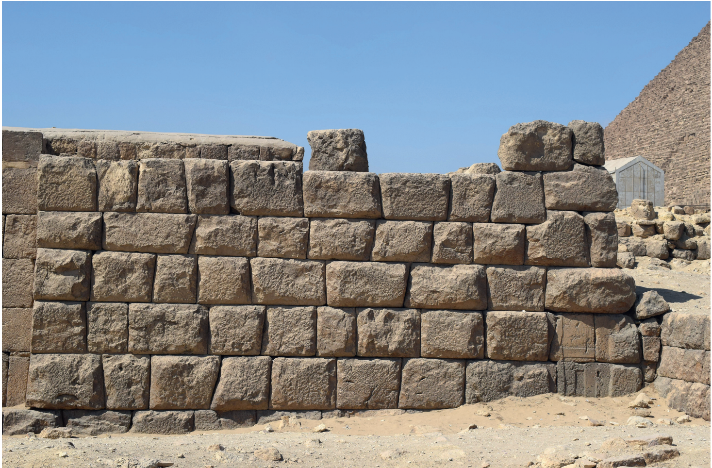
Fig. 110 Détail de la façade du mastaba de Sekhemânkhptah (G 7152) (Giza, CE). Fausse-porte externe sur le côté droit (nord).
