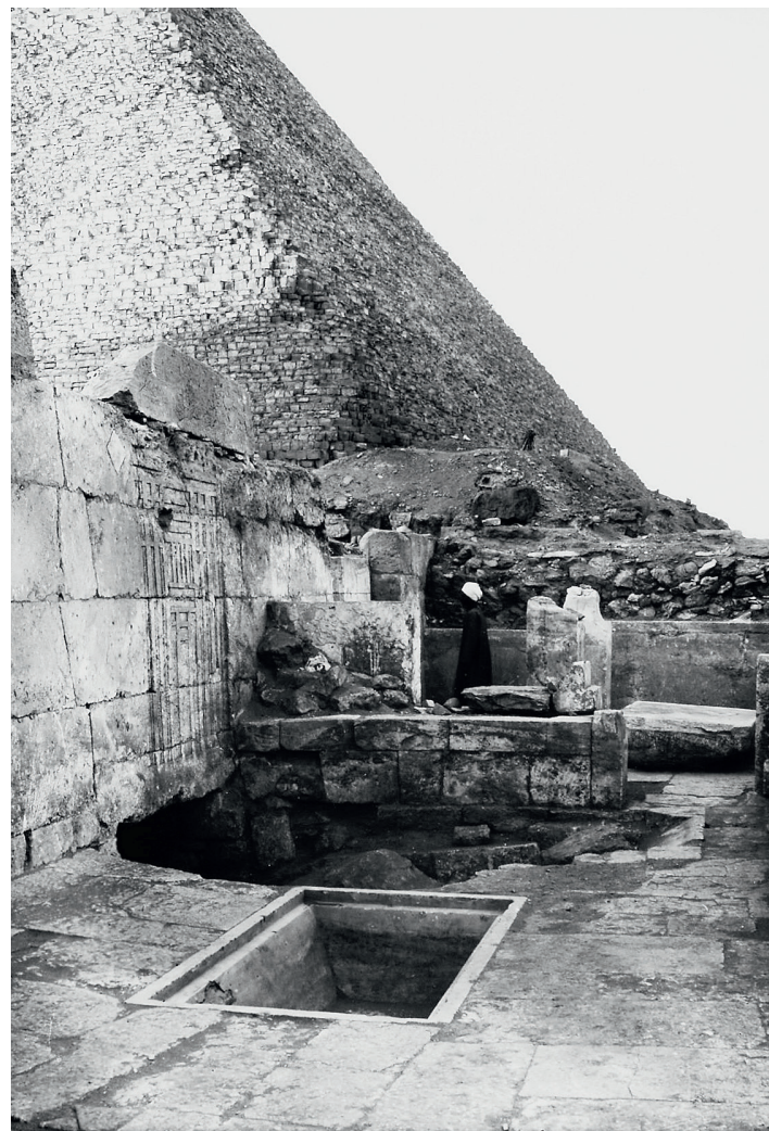
Fig. 113 Cour à ciel ouvert (B) du complexe de Sechemnefer IV [41] (Giza, GIS).
