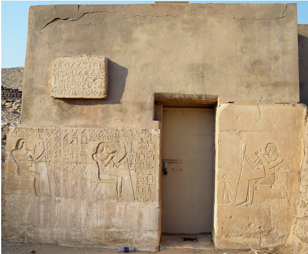
Fig. 30 Façade d'Inoumin [56] (Saqqara, CT).
