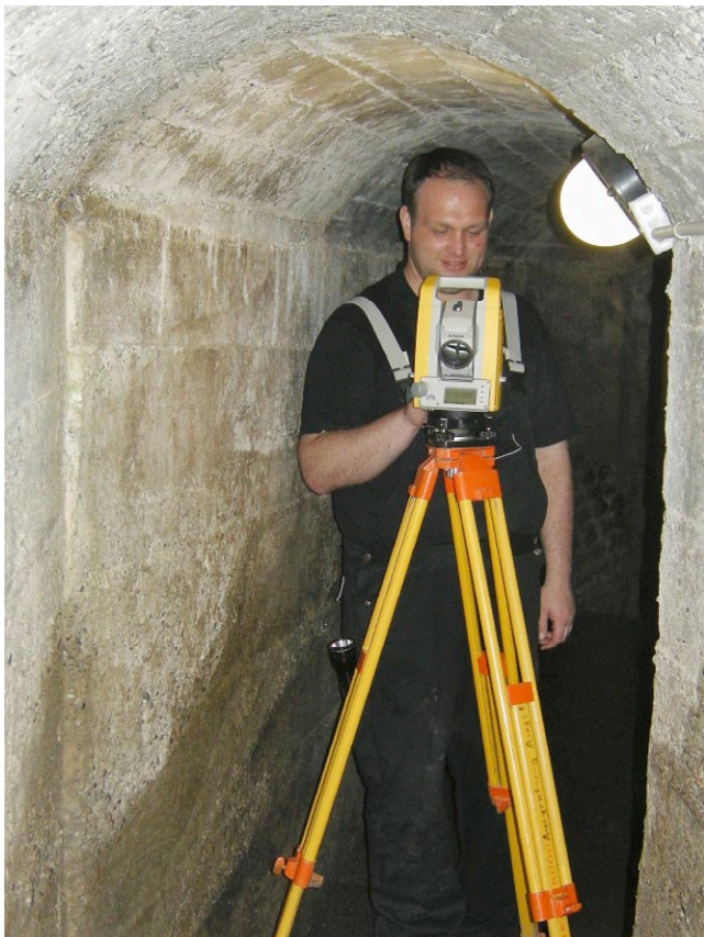
Daniel Schuhmann 2013 beim Einmessen des Kellerzugangs mit dem Tachymeter.
