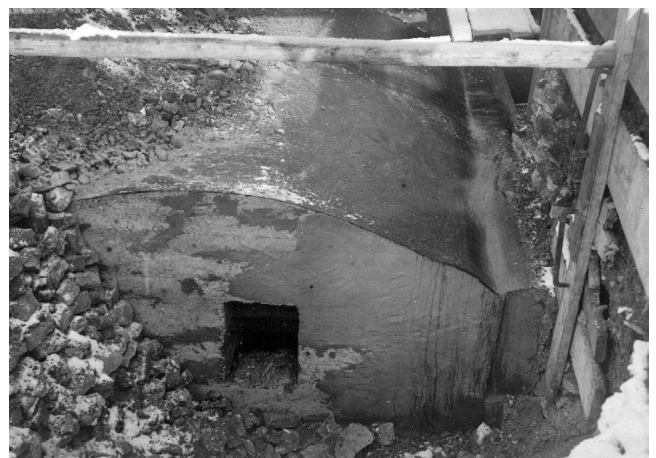
Der 1943 neu eingedeckte römische Keller wurde bereits nach der Ausgrabung 1944 mit einer gewölbten Betondecke wieder verschlossen. Fotograf unbekannt
