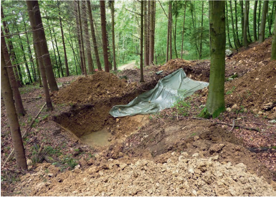
Abb. 84. Otelfingen-Hirzenrainweg/ Islochweg, Grabung 2010. Schnitt 2 unmittelbar nach der maschinellen Freilegung. Die Schichten wurden im Hinblick auf die geplanten Handabträge stufenartig abgebagert. Blickrichtung Südwest.
