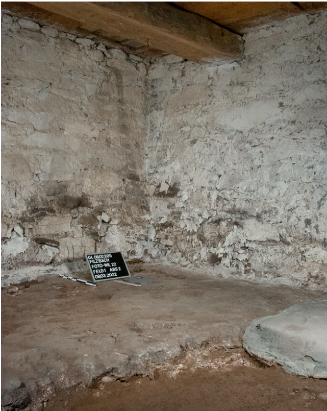
Abb. 10: Wachturm Filzbach (GL), Vordemwald. Blick auf die freigelegten Überreste des spätrepublikanischen/frühaugusteischen Mörtelgussbodens im Keller des «Hauses Menzi» (heute Liegenschaft Kerenzerbergstrasse 102).
