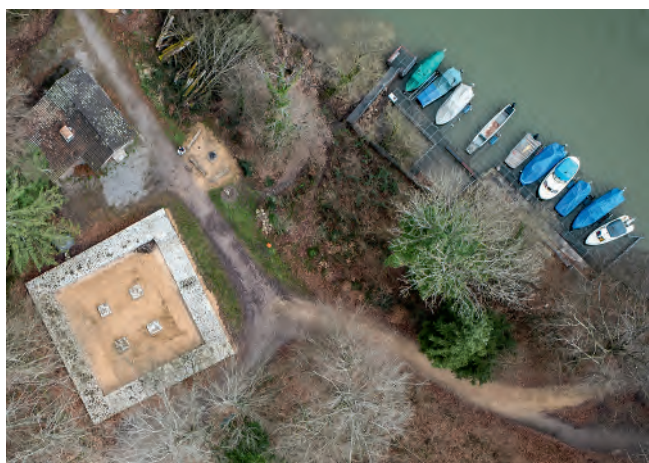
Abb. 1: Wallbach-Stelli (Wal.015.1/Wal.019.80). Die Ruine der Kleinfestung nach Abschluss der Sanierungsarbeiten (Zustand März 2020).
