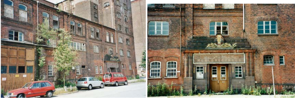
Abbildung 67: Gebäude der Harburger Mühlenbetriebe vor der Sanierung
