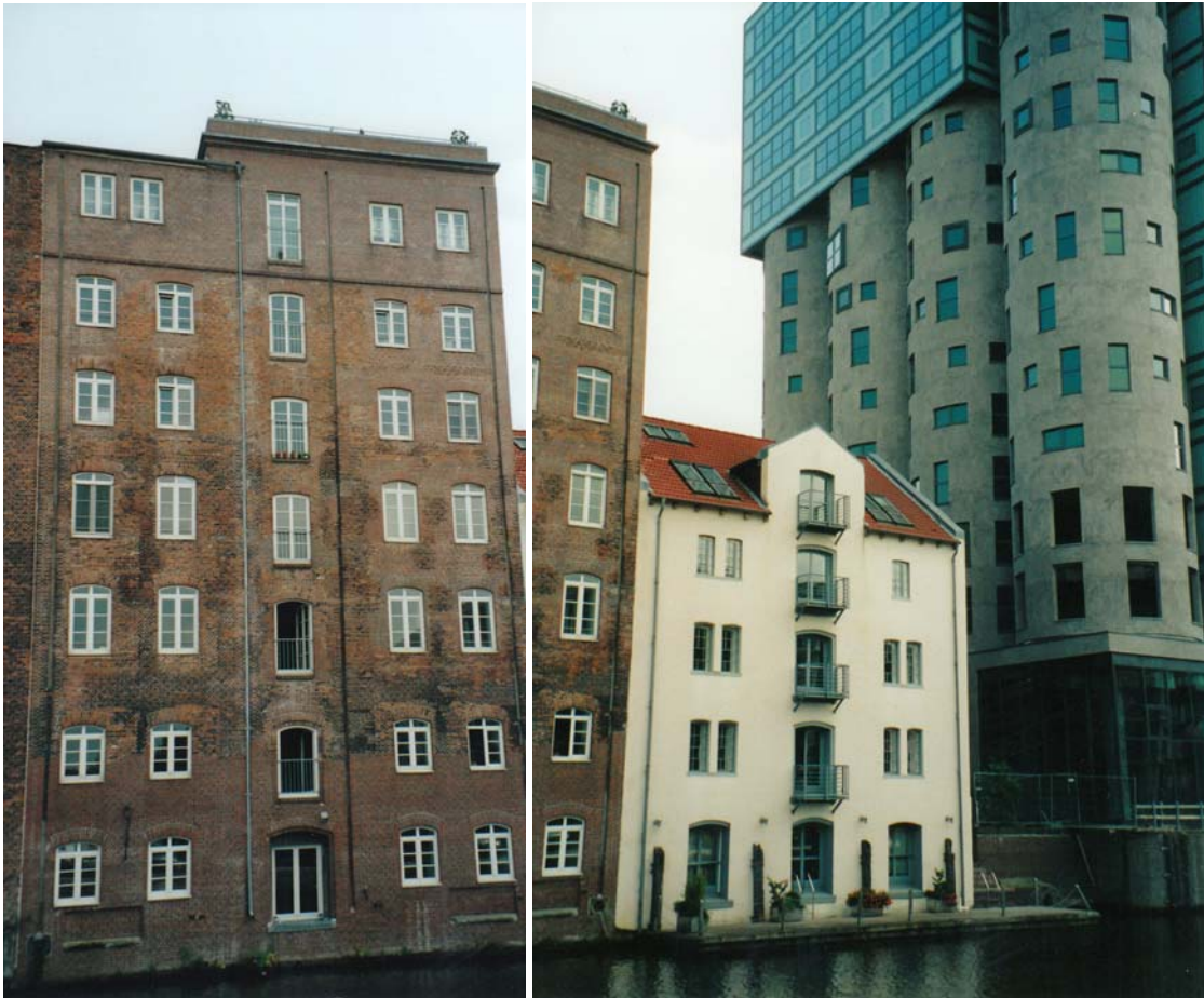
Abbildung 68: Gebäude der Harburger Mühlenbetriebe und angrenzende Bebauung nach der Sanierung
