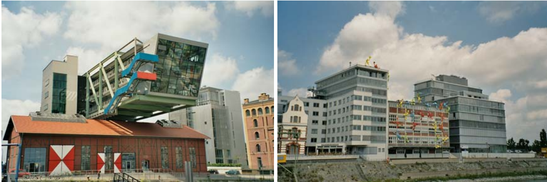
Abbildung 58: Port Event Center und Roggendorf-Speicher im Jahr 2004
